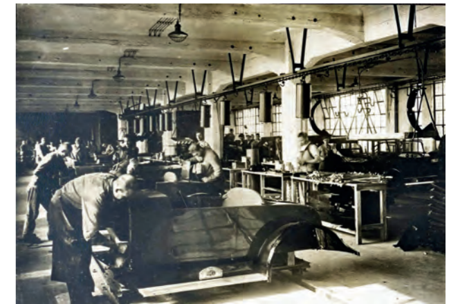
Auch im Karosseriebau erfolgt 1927 bereits die Fertigmontage der 4 PS-Karosserien. Die Einzelteile kommen auf Hängebahnen zum Montageort
