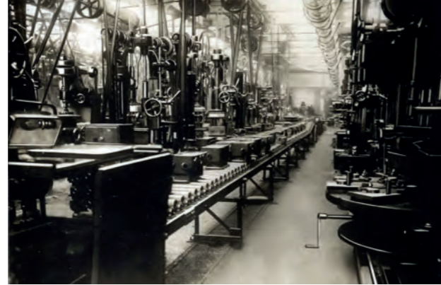
Teilefabrikation, hier Zylinderblöcke auf dem Rollenband
