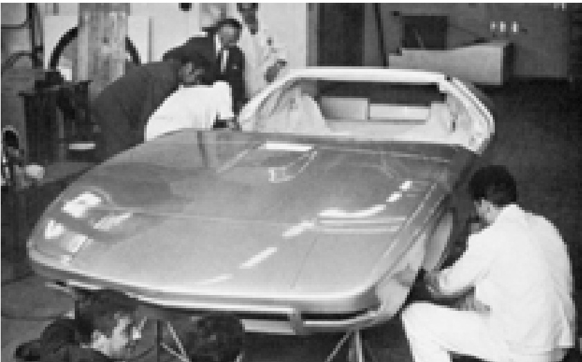
Der CD entsteht aus Fiberglas und wird kurz vor der IAA fertig
